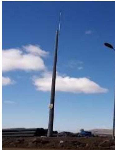
Sistema de Pararrayos
